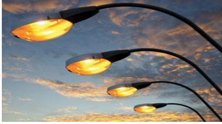
Fig. 4.2.3.2 – सोडियम व्हेपर लॅम्प (Sodium Vapour Lamp for Public lighting)
