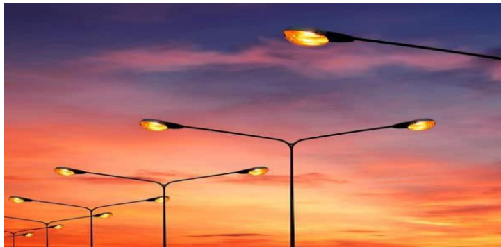
Figure. 4.2.3.4 – उच्च दाबाचे सोडियम व्हेपर लॅम्प (High pressure sodium vapour lamps for public lighting)
