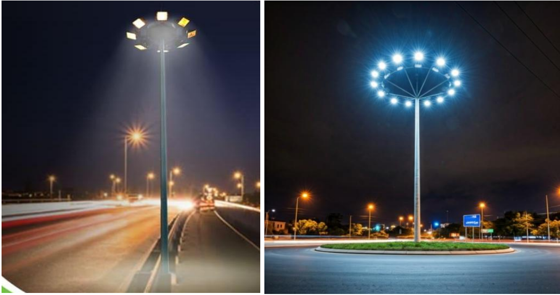
Figure. 4.3.1. – हाय-मास्ट स्ट्रीट लाइट्स (High Mast Street Lights)
