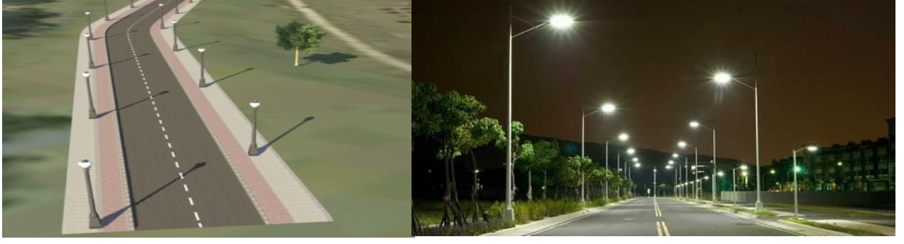
Figure. 4.1.5.2 – स्टॅगर्ड अरेंजमेंट (Staggered arrangement)
