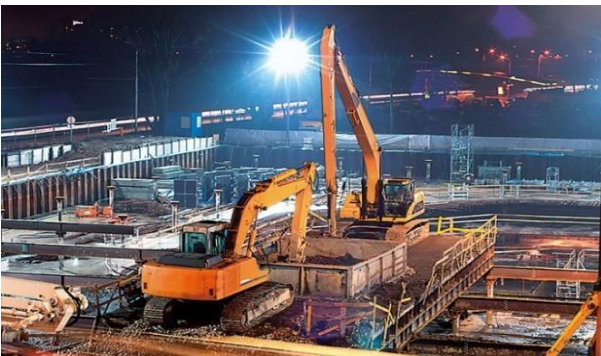
Figure. 4.1.1.3 - बांधकाम स्थळावरील स्ट्रीट लाइट
